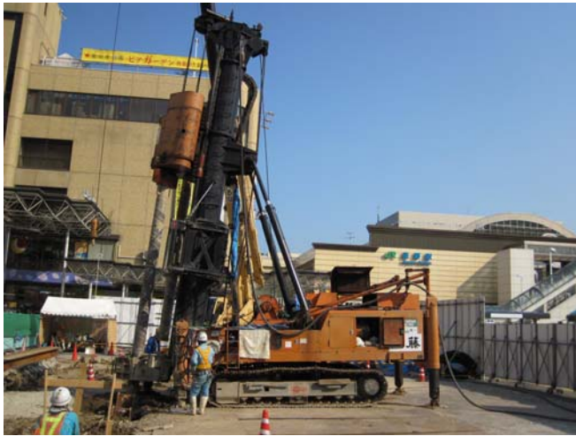
写真-3 アースオーガ先行削孔施工状況
