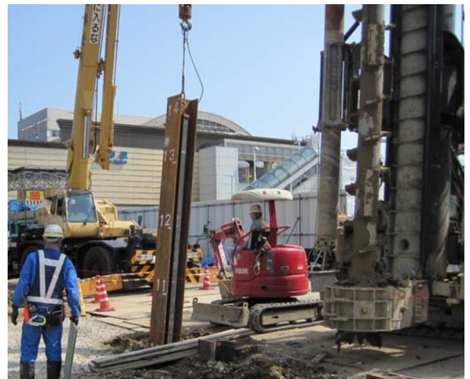
写真-6 親杭建込み状況
