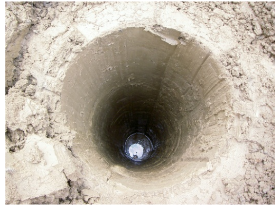
写真-5 削孔完了状況
