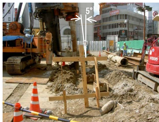
写真-9 丁張設置状況
