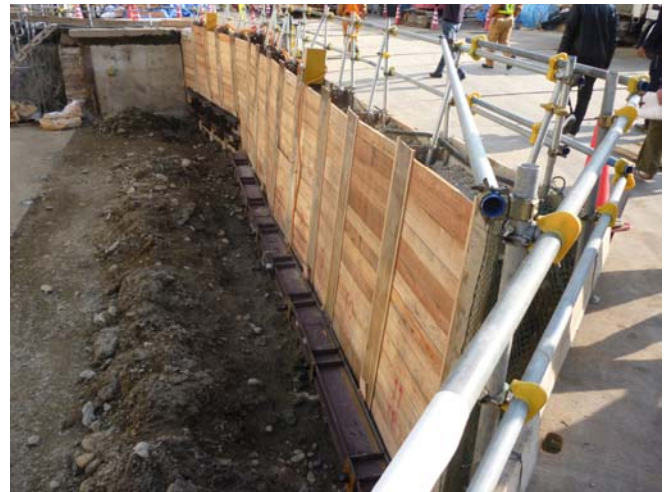
写真-11 1次掘削状況
