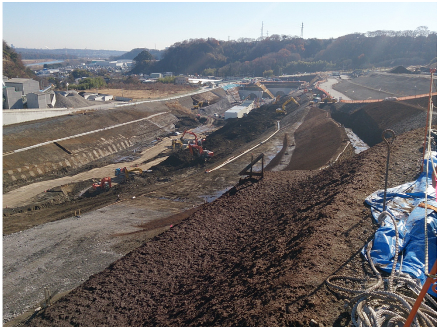
写真-3 さがみ縦貫角田三栗山地区改良（その 3）工事
