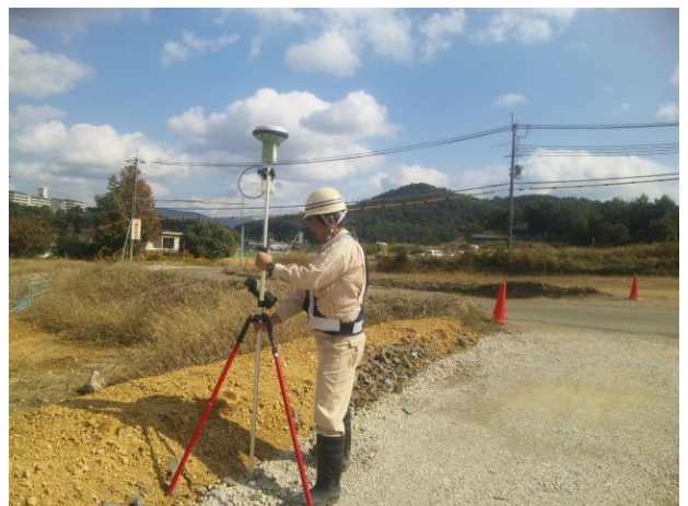
写真-4 現場測量作業状況
