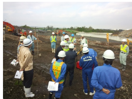
写真－5 国交省現場視察状況
