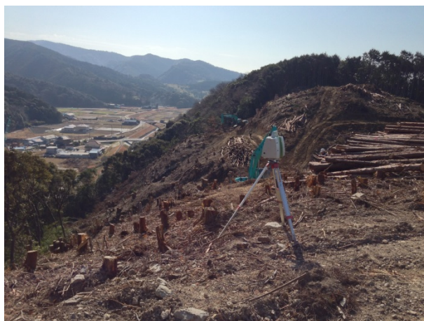
写真-1 3D スキャナー計測状況
