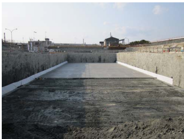
写真－9 掘削完了状況（均しコンクリート打設後）
