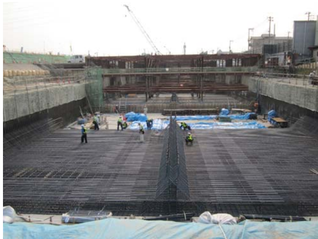
写真-10 鉄筋組立状況
