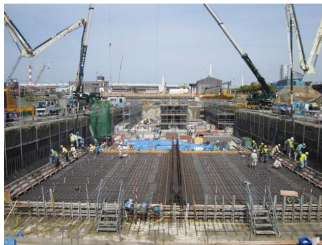
写真-11 コンクリート打設状況（底版部）
