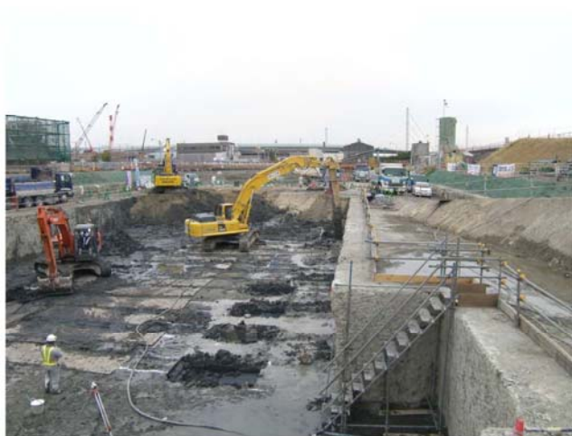
写真－7 底盤改良施工状況
