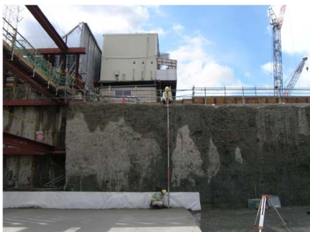
写真－8 掘削完了状況（自立高 5m）
