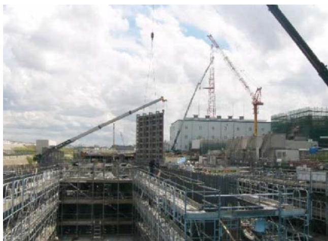
写真-12 大型型枠設置状況
