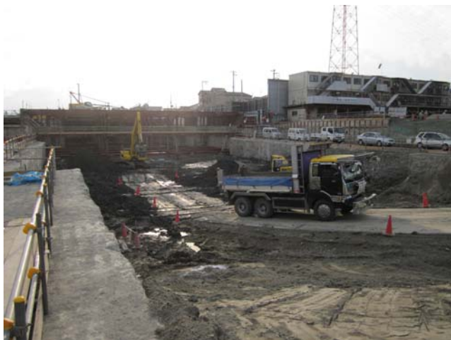
写真－6 掘削状況
