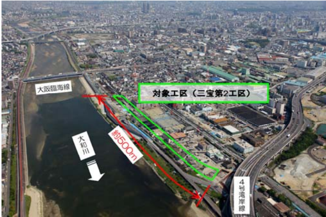
写真－１ 工事箇所状況（着手前）
