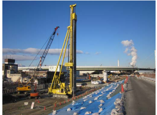
写真－2 地中連続壁（柱列式）施工状況
