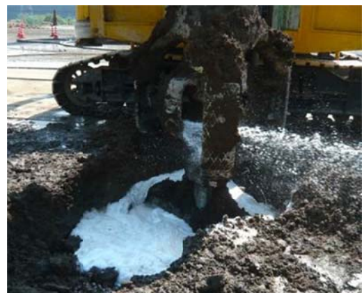
写真 5 攪拌翼からの気泡吐出状況
