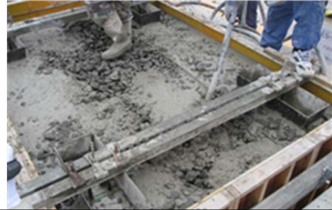
コンクリート殻の締固め混合状況(上層)
