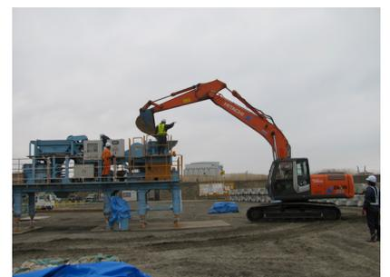
写真-1 材料投入状況
