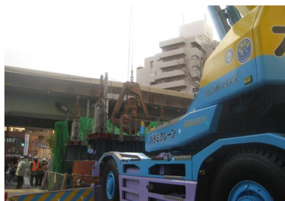
写真-2 立坑掘削工事
