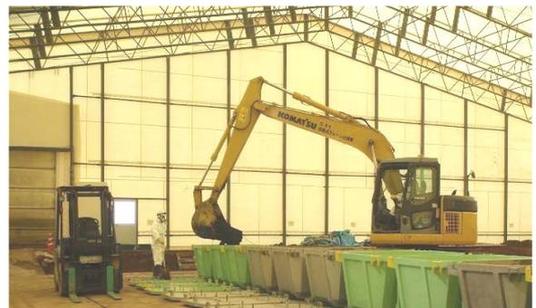
写真2 掘削建屋内での掘削状況
