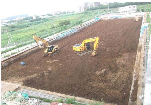
写真 13 掘削ヤード埋戻し状況
