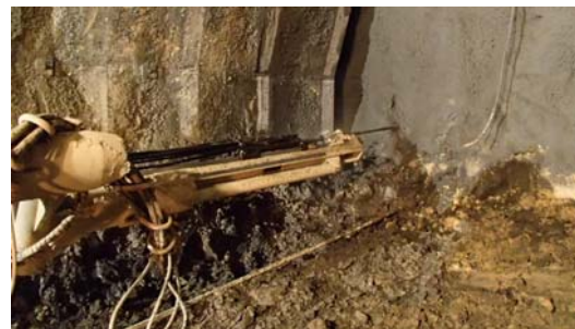
写真 8.3 上半脚部探りボーリング状況
