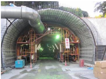
写真-6 セントル全景
