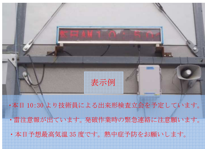
図 3.2.1 電工掲示板設置状況
