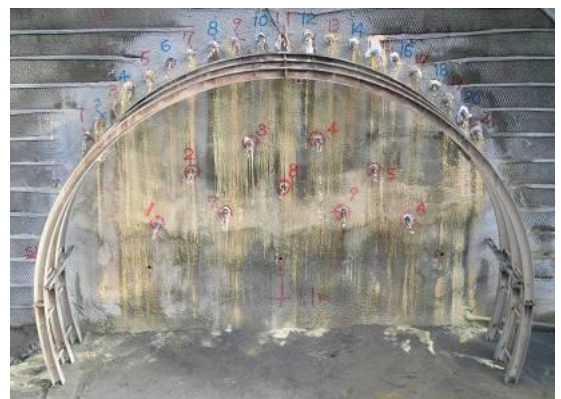
写真－9 施工完了状況
