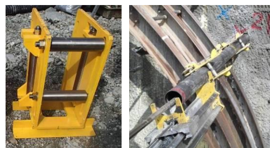
写真－3 特殊鋼管受け治具
