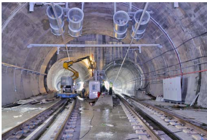
(a) COL 断面から COS および TBM 断面を望む
