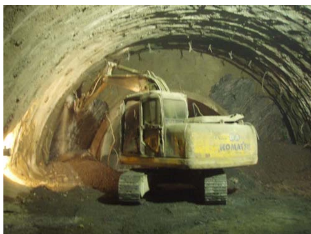
写真 2 TBM 断面から COM トンネルへの切詰め
