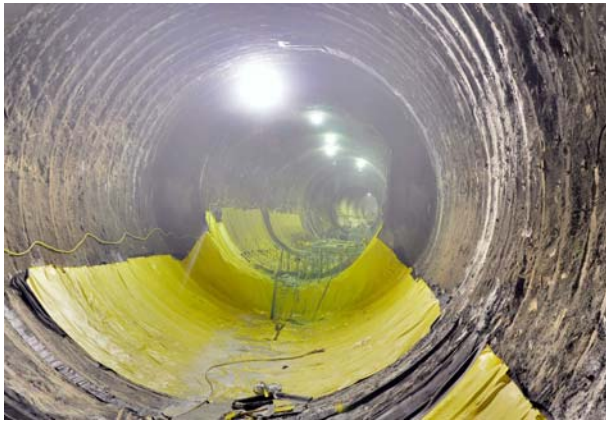
(a) COL インバートコンクリート施工状況
