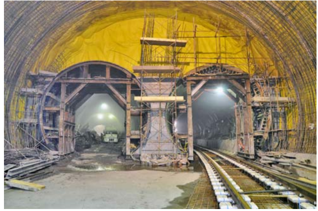
(b) COL アーチコンクリート施工状況
