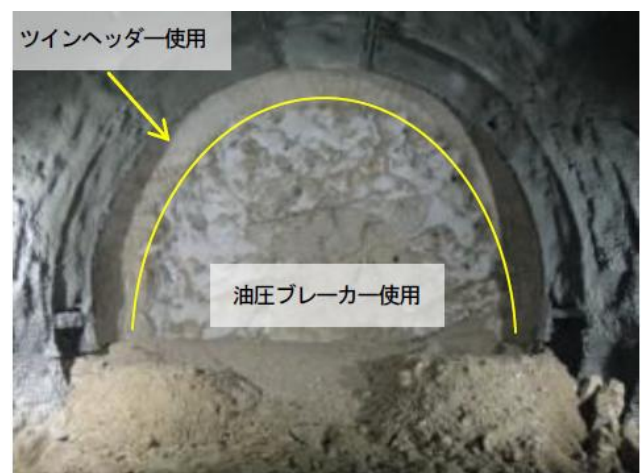
写真—3 切羽状況
