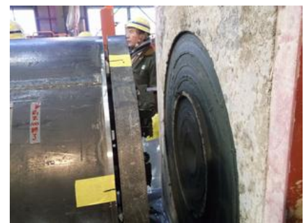
図-7. 掘進初期状況
