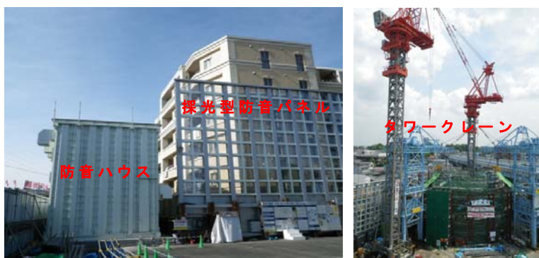
写真-5 ケーソン施工時の周辺環境対策例
