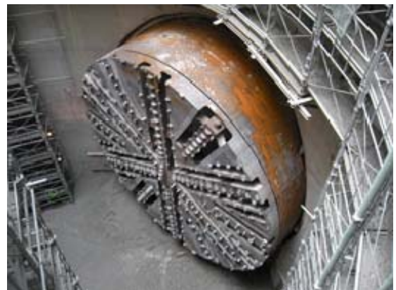
写真-8 シールド到達状況
