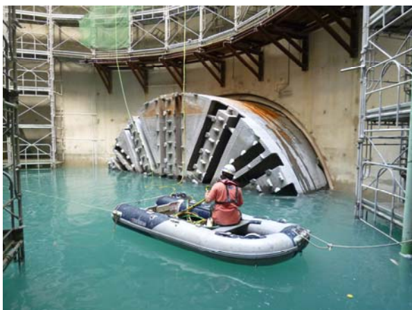
写真-7 立坑内排水状況
