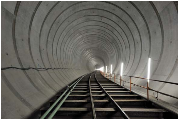
写真-4 シールドトンネル坑内
