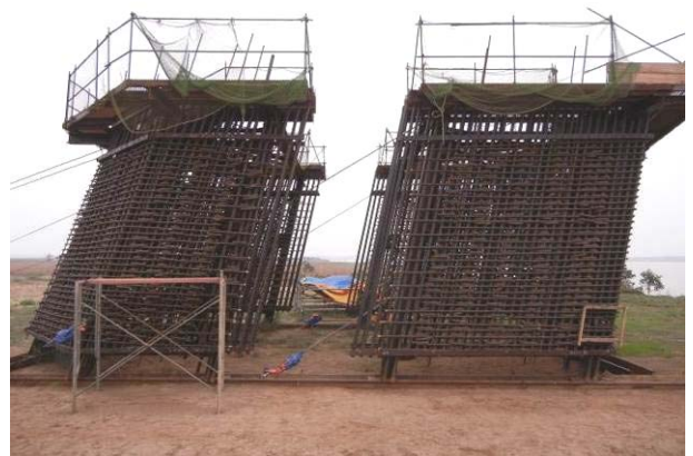
写真-8 2 分割で地組されたプレファブ鉄筋
