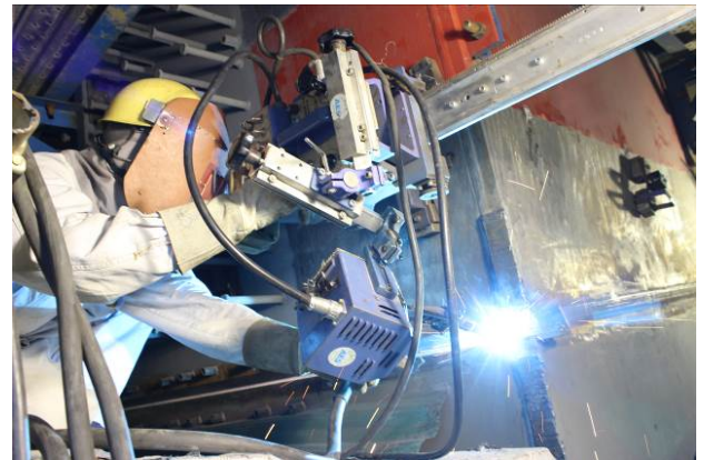
写真-10 アンカーボックスの溶接状況
