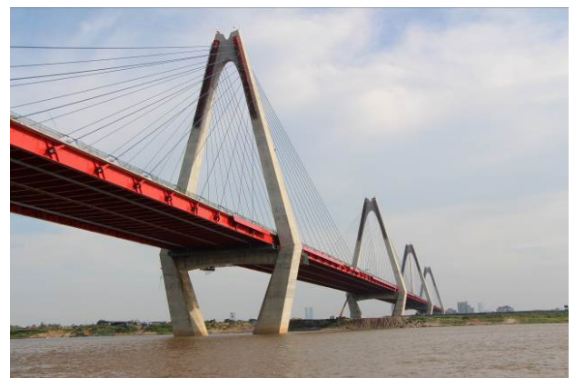
写真-12 完成した主塔と上部工
