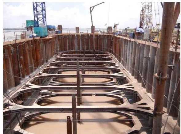
写真-3 井筒内排水と山留め設置状況
