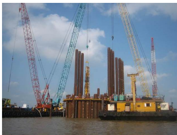
写真-2 ディーゼルハンマによる上杭の打設
