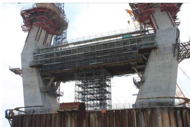
写真-9 クロスビームの施工状況
