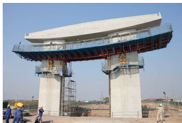
写真-7 セルフクライミング梁形式支保工
