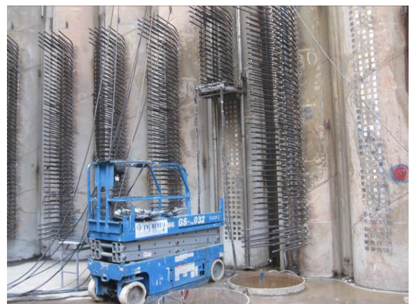
写真-4 多連自動溶接機による鉄筋スタッド溶接
