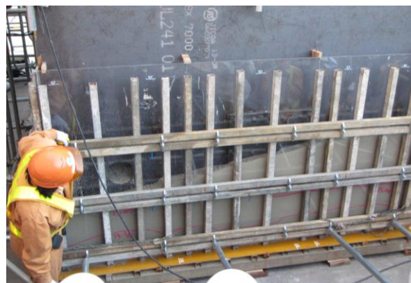
写真-2 充填実験状況(厚さ 130mm) (既設橋脚周囲のモデル化)
