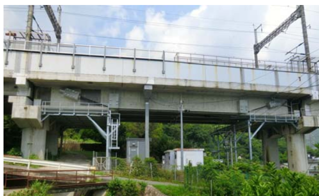
写真-1 外ケーブルの設置状況
