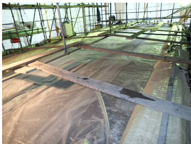
写真-5 保温・保湿養生
