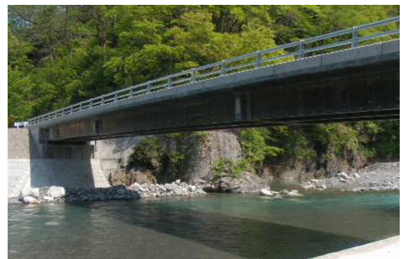
写真-1 完成写真
