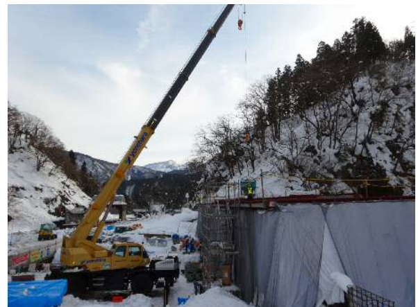
写真-3 打込み状況
