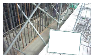
図-9 コンクリート打設状況
