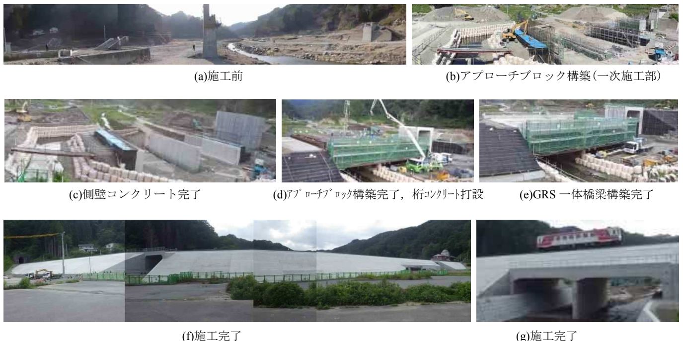
図-11 松前川橋梁施工状況
