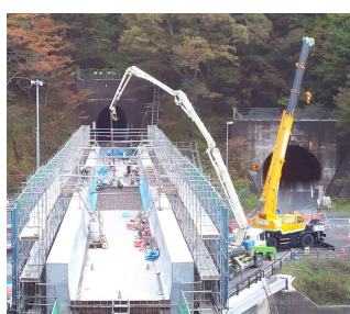
(f)コンクリート打設
