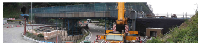
(d)起点方径間鋼桁架設
