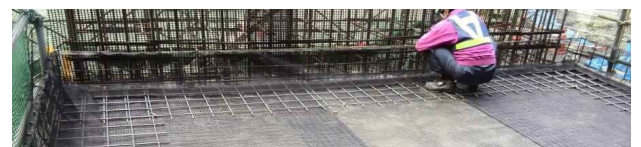
図-7 ジオテキスタイル・溶接金網設置状況
