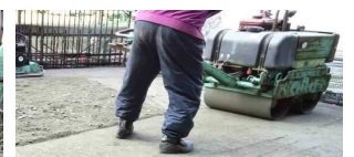
図-8 (b)転圧状況
