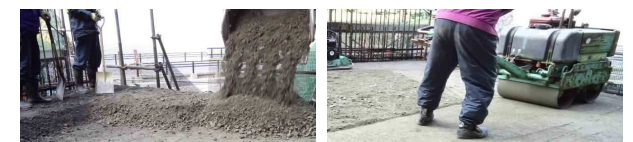
図-8 (a)撒出し状況
