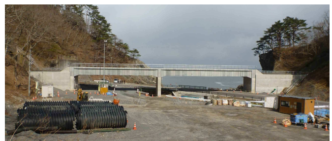
(g)施工完了
