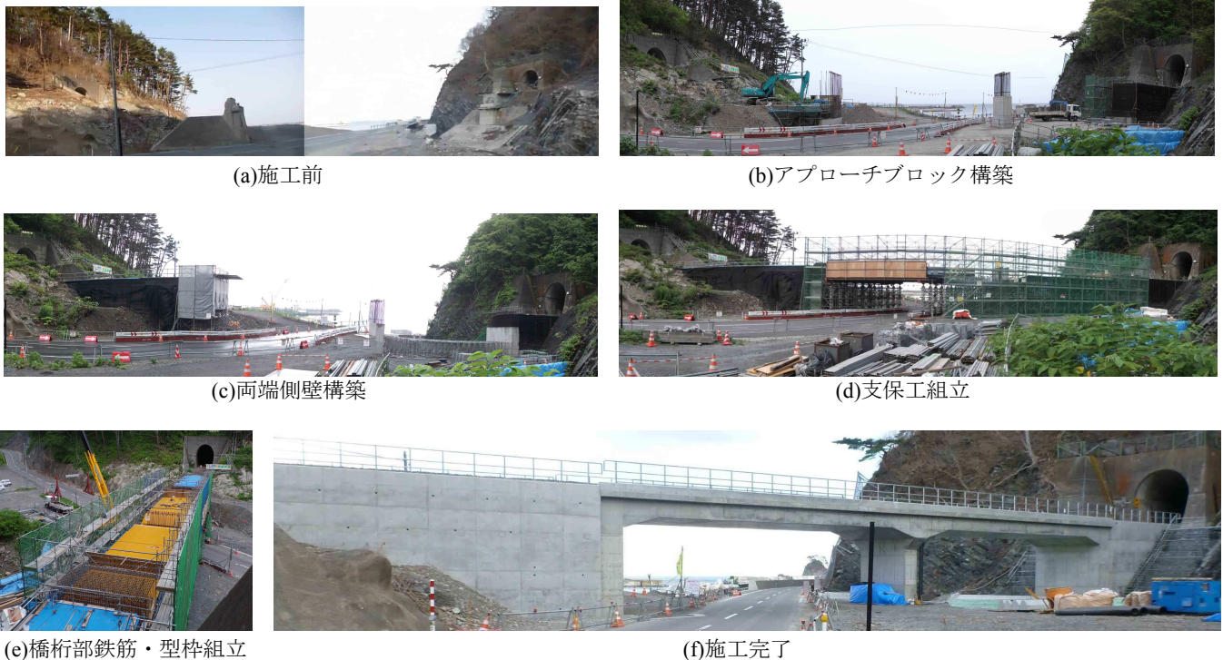
図-13 コイコロベ沢橋梁施工状況
