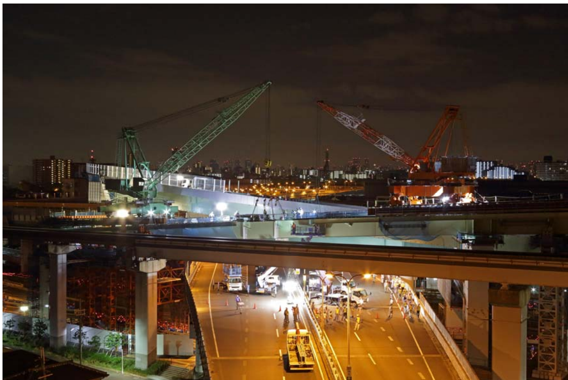
写真—５ トラベラクレーンによる寝屋川バイパス上の桁架設
