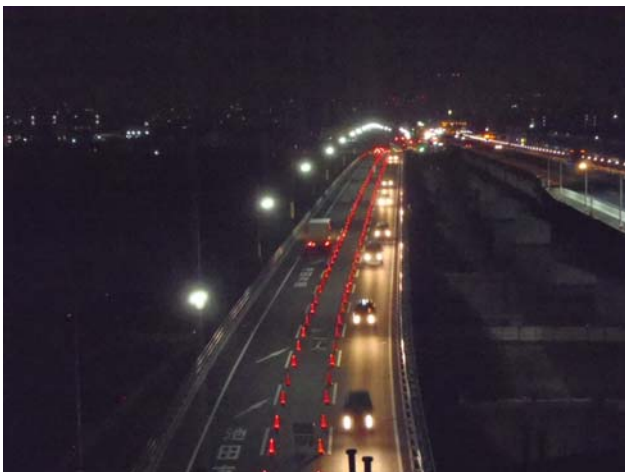
写真一 3 対面通行時全景
