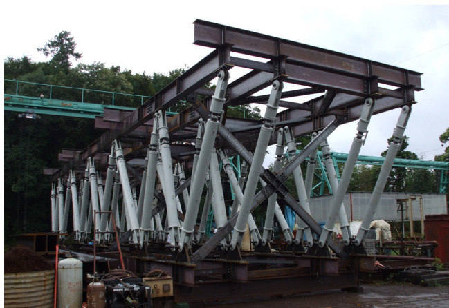
写真-2 トラス桁の仮組立状況
