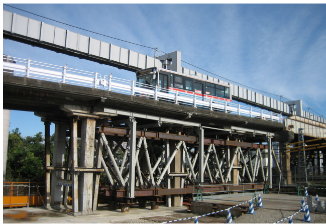
写真-3 アンダーピニング完成
