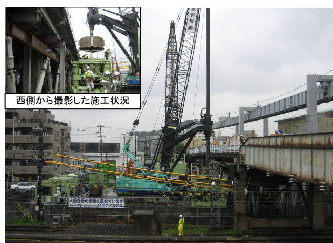
写真-4 場所打ち杭施工状況
