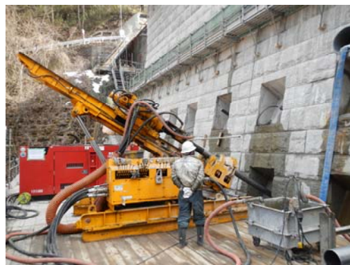
写真-2 削孔状況
