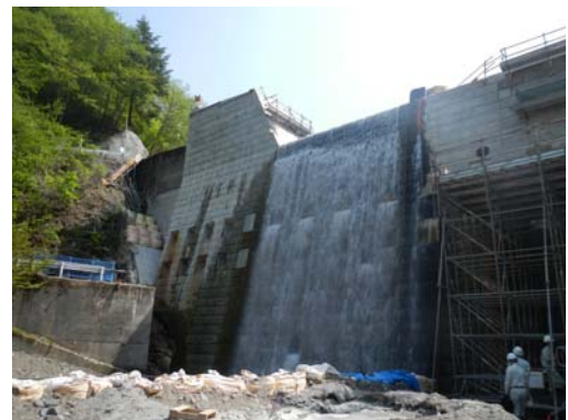
写真-1 砂防堰堤全景
