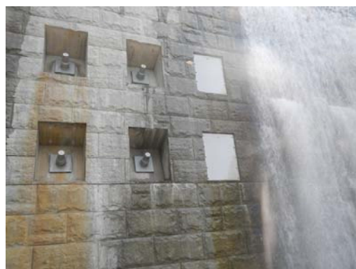
写真-5 越流部頭部保護
