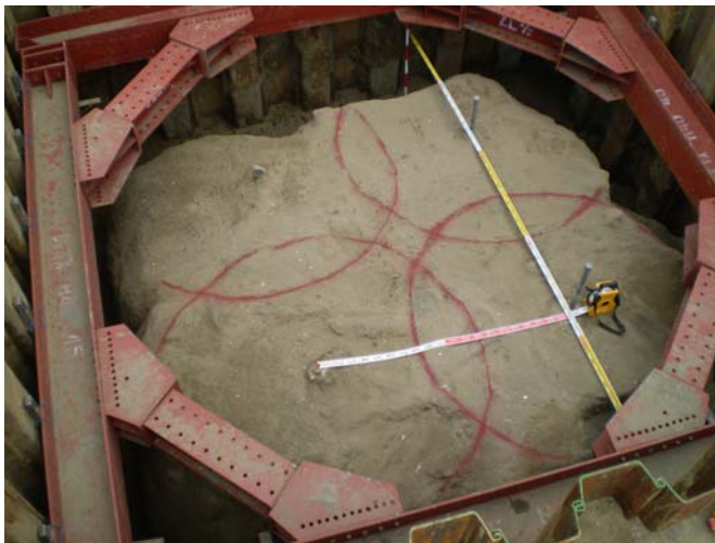
写真1 改良体発掘全景 (GL-1.30m)
