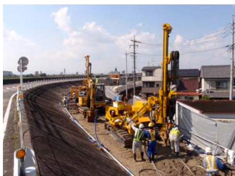
写真-6 施工状況
