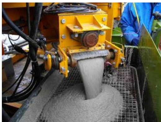
写真-1 圧送される流動化砂の状態
