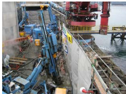
写真-3 施工状況（全景）
