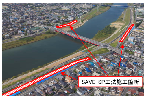
写真-5 施工箇所の一例
