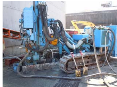
写真-4 施工状況（近景）
