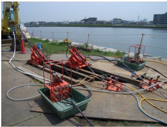
写真-8 注入状況
