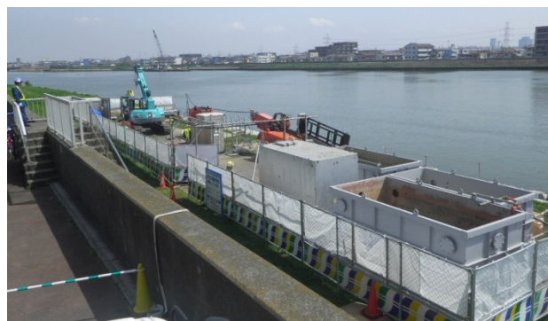
写真-6 施工ヤード全景
