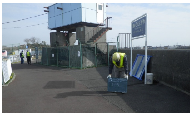
写真-7 液状化対策工事の対象構造物（水門）
