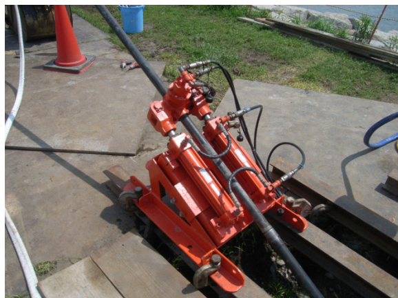
写真-4 鋼製注入管引抜装置
