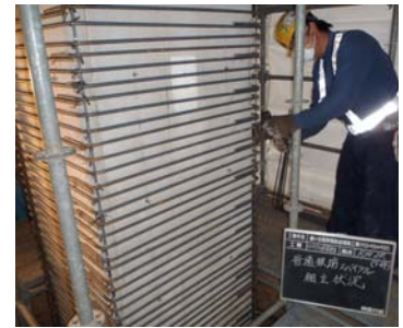
写真－１ 普通鉄筋の組立状況
