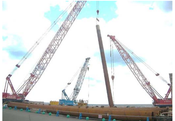
写真-11 ケーソン補強杭（鋼管）建込状況
