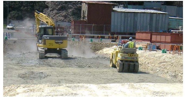
写真-9 排泥による埋戻し状況
