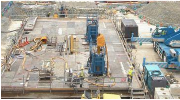
写真-8 ジェットクリート施工状況
