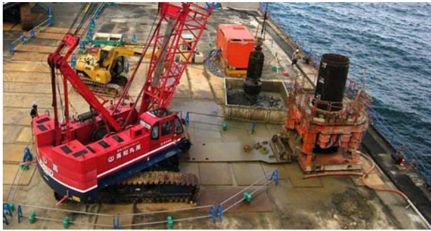
写真-10 オールケーシング工法による削孔状況
