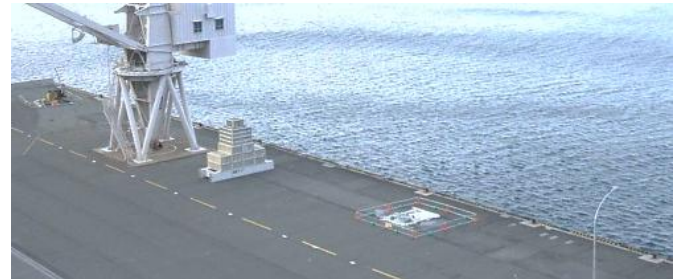
写真-1 荷揚岸壁全景（補強工事着手前）
