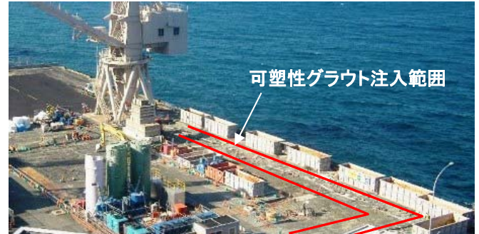
写真-5 可塑性グラウト施工状況
