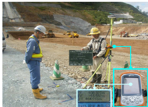
図-9 RTK GNSS 測量状況
