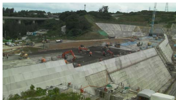
写真-1 億首ダム施工状況
