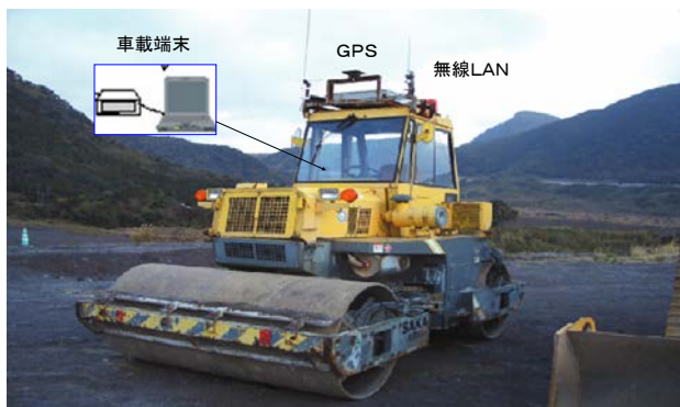
写真-2 転圧ローラ
