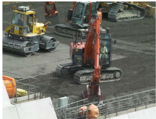
写真-3 端部法面締固め実施状況
