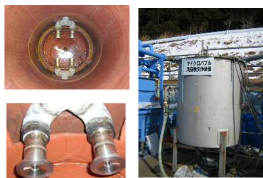
写真-4 マイクロバブル渦崩壊洗浄装置
