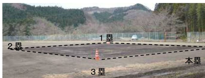
写真-1 試験場所(破線内：野球場内野を削り取り)
