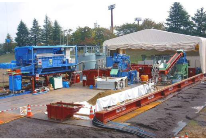
写真-6 プラント設置状況
