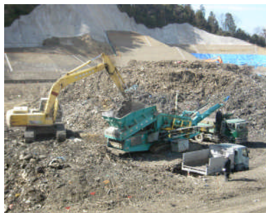
写真－2 分別状況（振動スクリーン）
