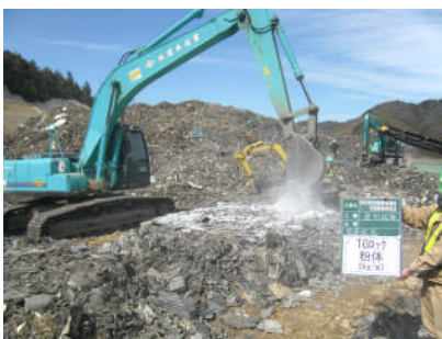
写真－1 改質状況
