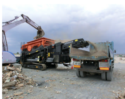
写真-5 分別状況（振動スクリーン）
