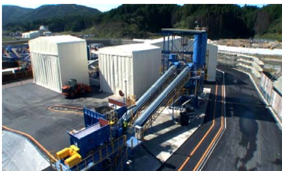
写真－1 造粒固化処理施設
