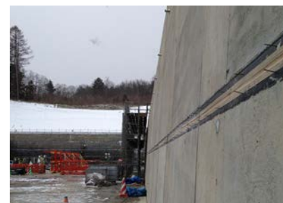
写真－5 ガイドレール設置完了状況
