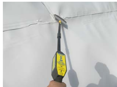
写真－4 スパーク試験実施状況
