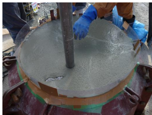
(b) モルタル注入状況
