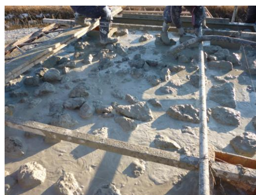
(b) モルタル注入（仕上げ）状況
