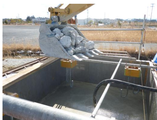
(a) がら投入状況
