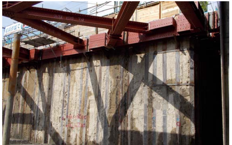
写真-6 ソイルセメント壁
