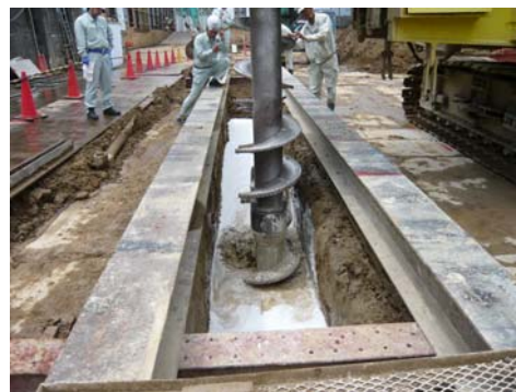
写真-3 施工状況
