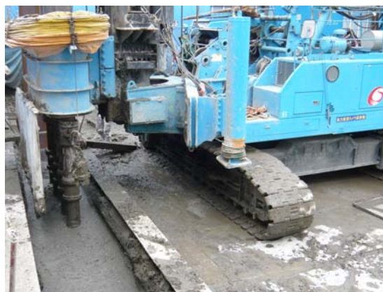
写真-5 施工状況（実施工 5軸オーガー）
