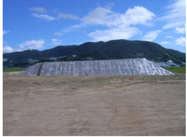
写真-2 第2工区の盛土状況
