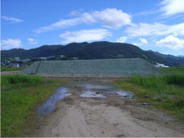
写真-1 第1工区の盛土状況
