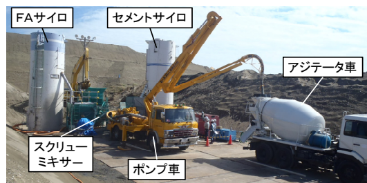
(a) プラントでの積込状況
