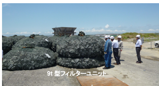
写真－５ 9t 型 FU（陸上ヤード）
