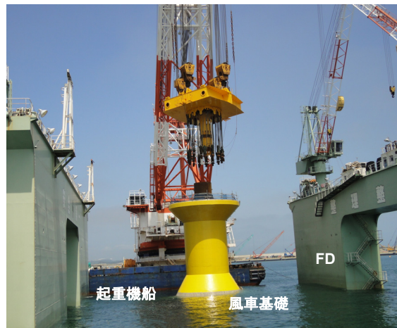
写真-2 基礎積替状況
