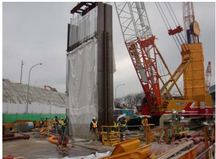
写真-2 鉄筋カゴ建込み状況
