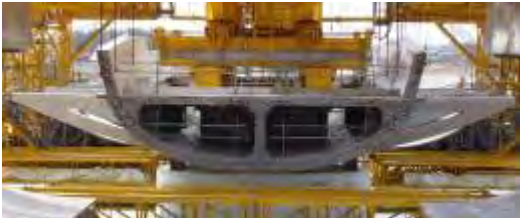
写真－1 主桁断面
