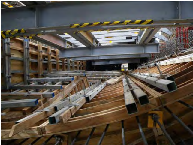
写真－２ 桁内状況
