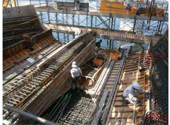
写真－３ 内枠組立て状況
