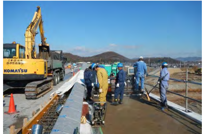
写真－１０ 歩道部 舗装状況
