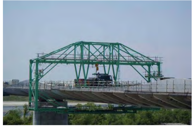
写真－６ 橋面移動作業台車
