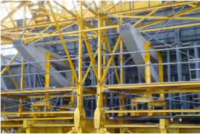
写真－５ ブラケット据付状況
