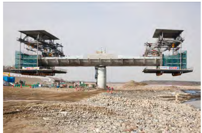
写真－４ 移動作業車を用いた張出し架設状況 (P9 橋脚)
