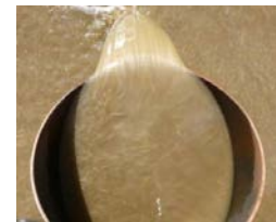
写真 12 吐口排水状況
