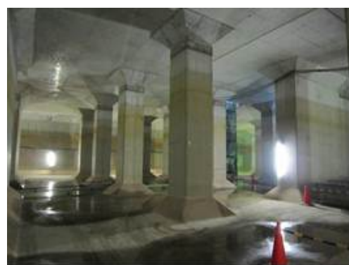
写真－4 配水池内外観
