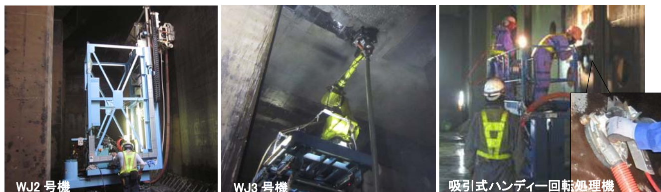
写真－6 塗膜除去状況
