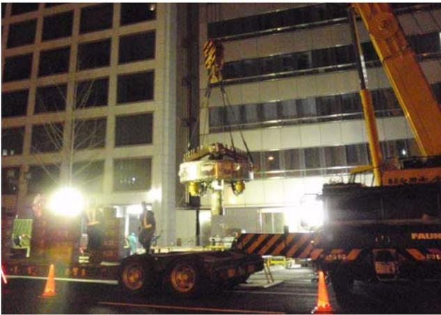
写真- 4 上向きシールド到達回収状況
