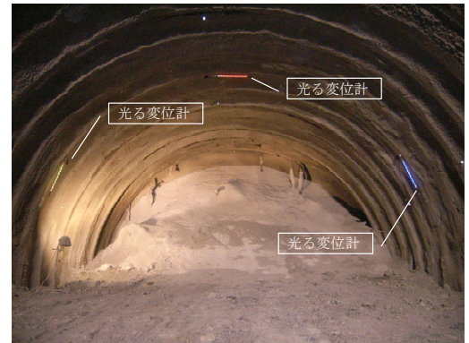
写真-4 切羽における設置状況 3)
