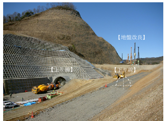
写真-6 トンネル施工状況 4)
