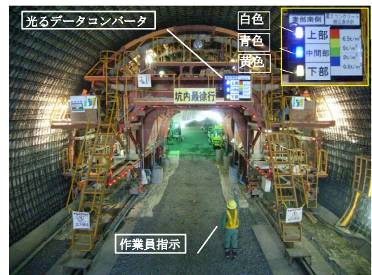
写真-7 中流動覆工コンクリート圧力管理状況 4)
