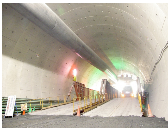
写真-6 セグメント覆工完了状況
