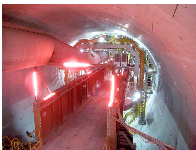
写真-5 セグメント組立て状況（中央栈橋）
