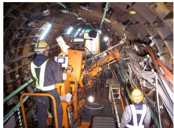
写真-2 削孔状況
