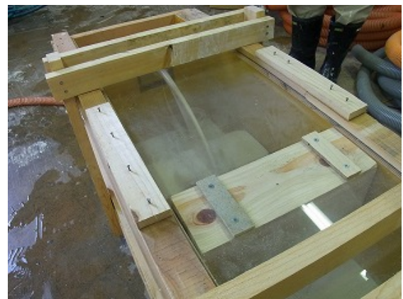
写真 3-10 充填材打設状況
