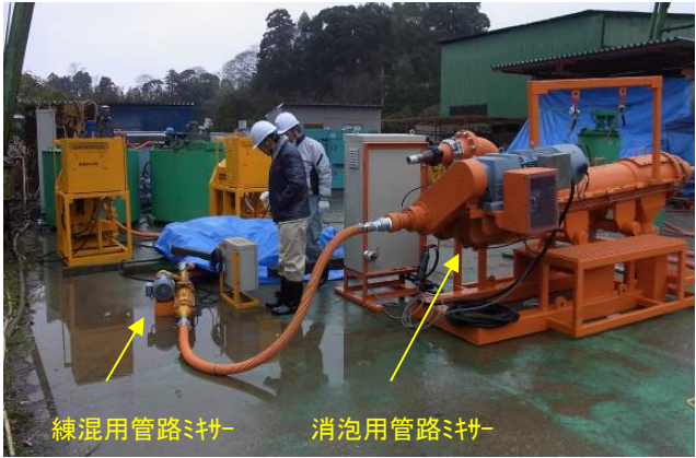
写真 4-1 大容量試験施工状況
