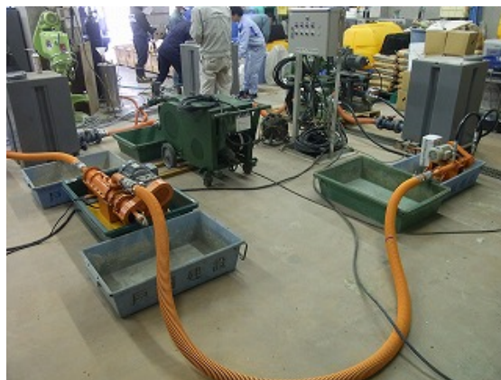
写真 3-2 管路ミキサー
