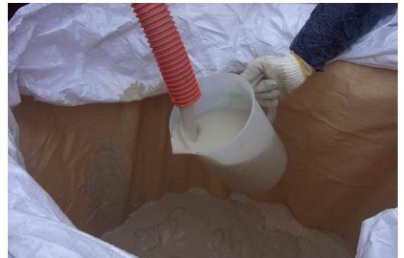
写真 4-2 充填材打設状況(ケース 2)
