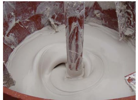
写真 4-3 ミキサープラントによる練混ぜ状況
