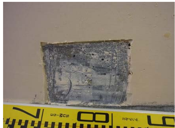
写真 3-12 コンクリートブロック充填確認状況
