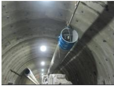
写真-4 伸縮風管取付状況
