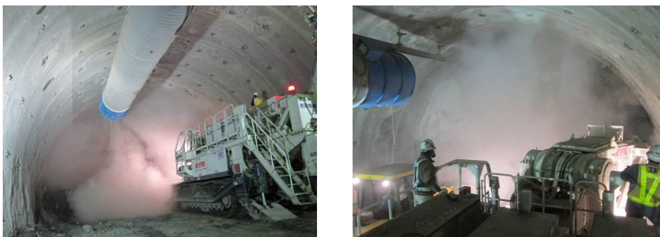
写真-8 実掘削状況
