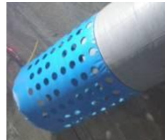
写真-5 特殊噴出ダクト
