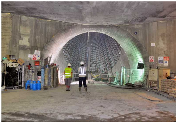
写真-6 ISL 斜坑二次覆工施工状況
