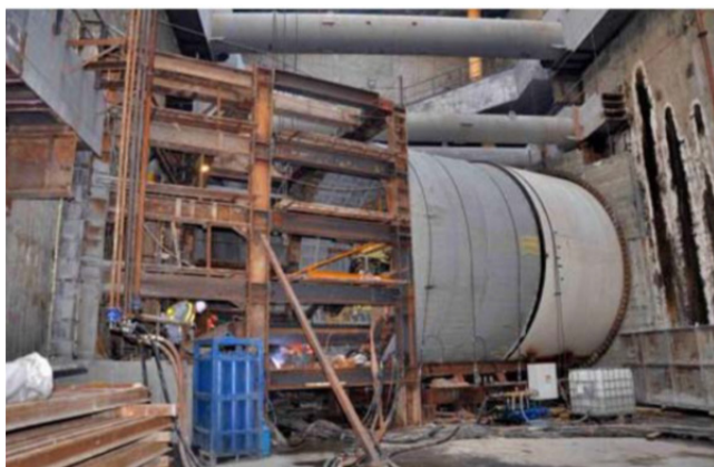
写真-3 北側エントランストンネル TBM
