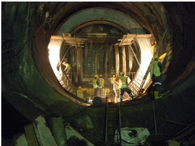
写真-4 NE および接続部 SRC 施工状況
