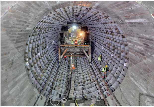
写真-5 鋼製セグメント構築状況
